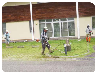
日出町 SC 除草作業
