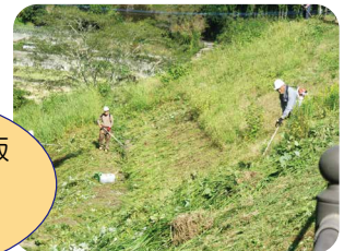
日田市 SC 除草作業
