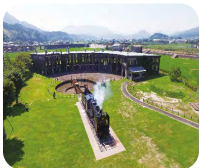
機関庫公園と蒸気機関車とミニ SL 線路
